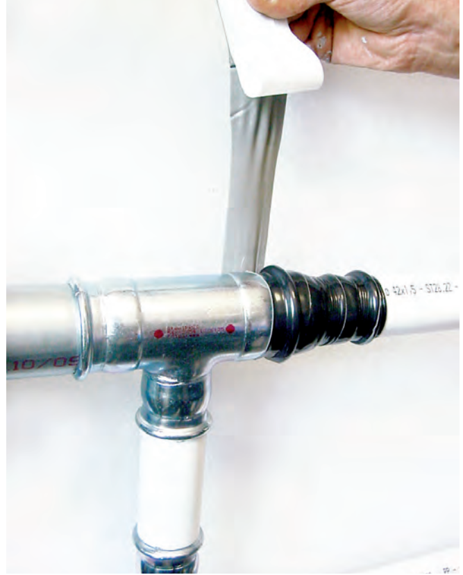
Şekil 38 - Konektörlerin bütanol yapıştırıcı bant ile korunması
