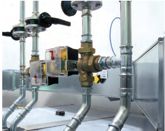
Şekil 22 - steelPRES - soğutma (kapalı devre)
