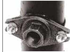
6. Montaj tamamlandı Assembly completed
