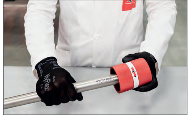
Borunun çapağının alınması / Deburring the pipe
