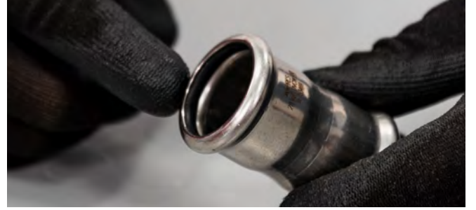
Şekil 30 - Sızdırmazlık halkasının kontrol edilmesi
