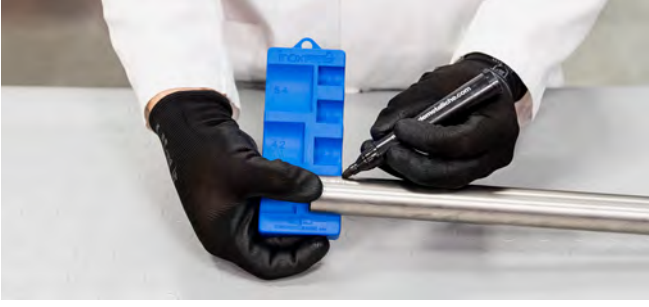
Şekil 28 - Yerleştirme derinliğinin işaretlenmesi
