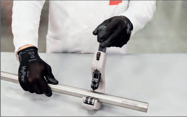
Borunun uzunluğa kadar kesilmesi / Cutting the pipe to length
