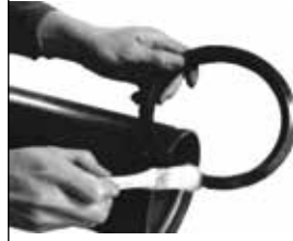
2. Contayı yağlayın Lubricate gasket
