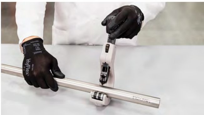
Şekil 25 - Borunun boyuna kesilmesi
