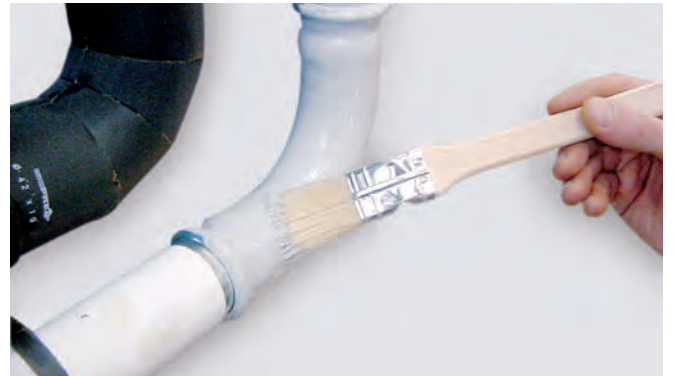
Şekil 37 - Bağlantıların ve boruların astar ile verniklenmesi.
