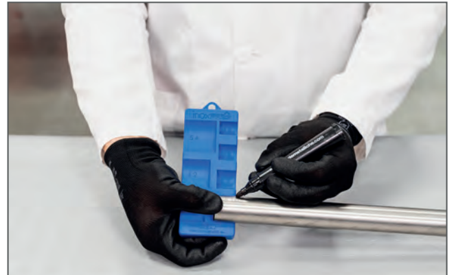
Ekleme derinliğinin işaretlenmesi / Marking the insertion depth
