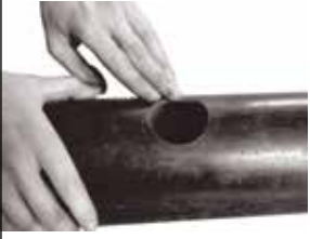
1. Boru hazırlığı Pipe preparation
